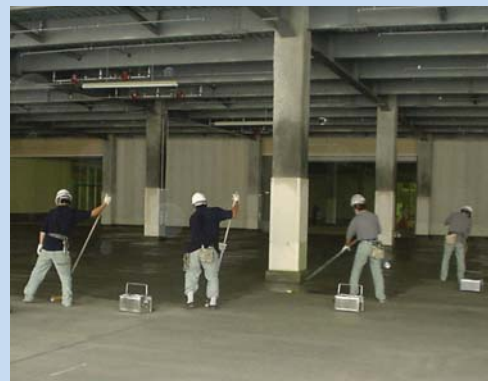
CS-21 塗布状況
