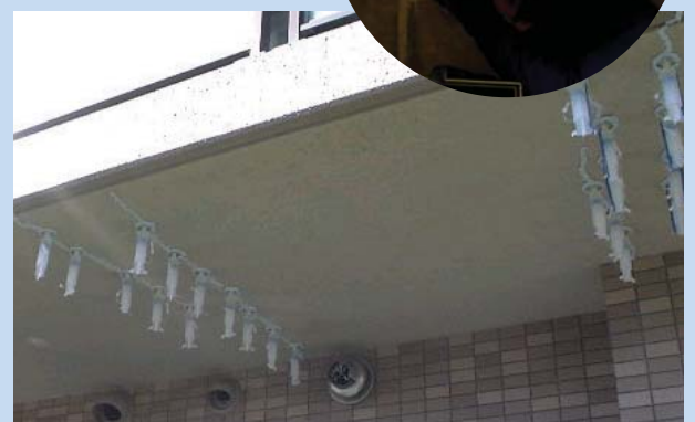
CS-21注入状況
