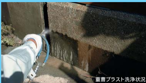
重曹プラスト洗浄状況
