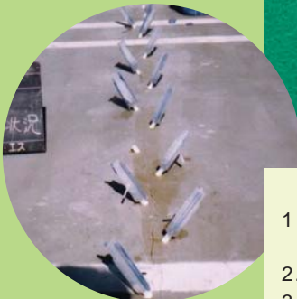
CS-21 注入状況
