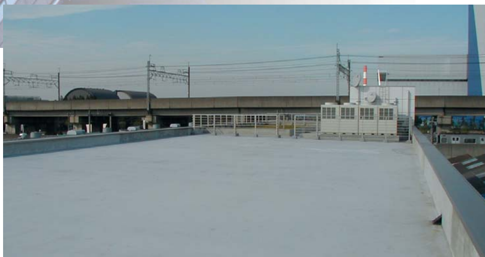
ビル屋上床版
