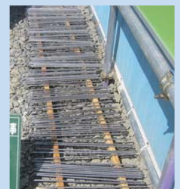
セパレータCS-21塗布後乾燥養生状況
