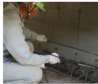
打継部処理CS-21散布状況
