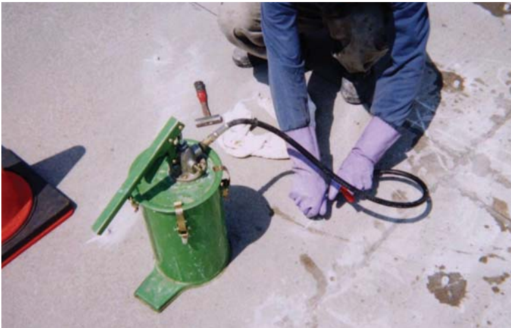
ケミカルポンプによる注入状況
