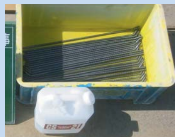
セパレータCS-21塗布(どぶ浸け)状況
