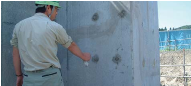
木コン処理CS-21散布状況
