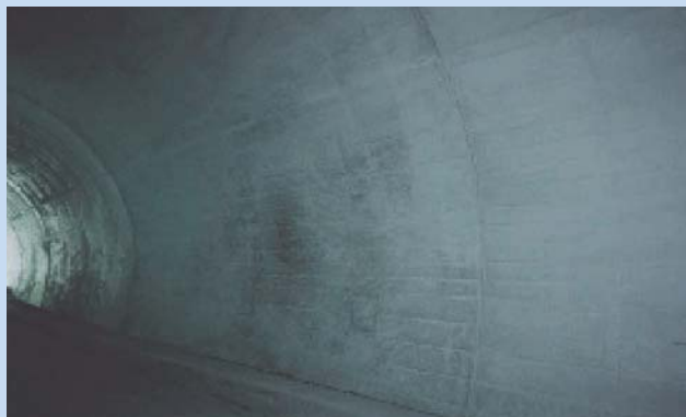
トンネル改修
