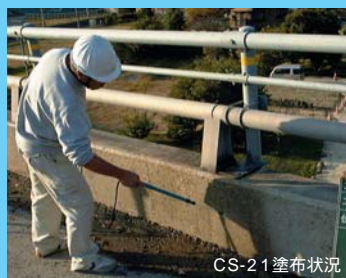
CS-21塗布状況
