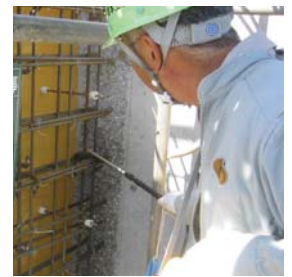
打継部処理CS-21散布状況
